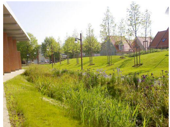
Figure 2 : Exemple de noue d'infiltration n°2
