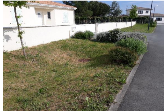
Figure 1 : Exemple de noue d'infiltration n°1
