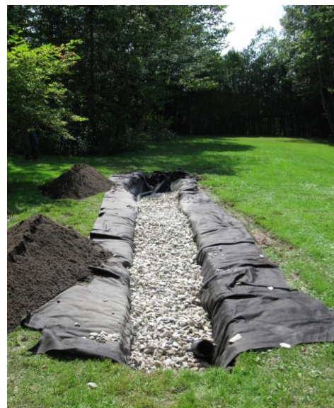
Figure 1 : Exemple de tranchée d'infiltration
